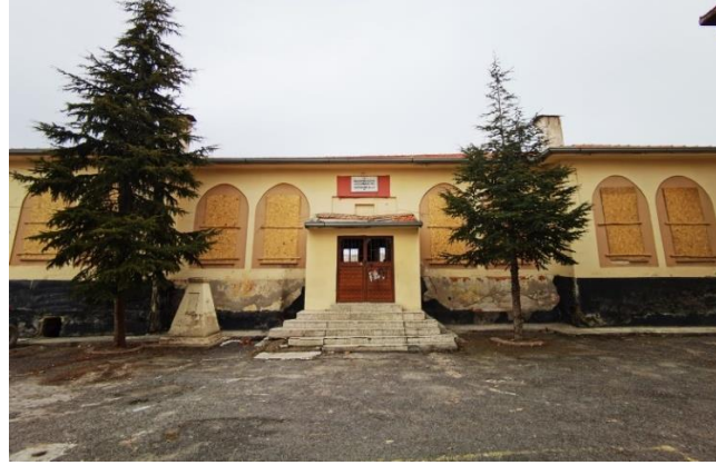
Görsel 11. Çat Cumhuriyet İlköğretim okulu batı cepheden görünüm
