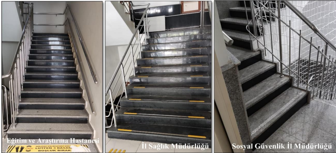
Şekil 4. Kamu binaları merdivenleri
