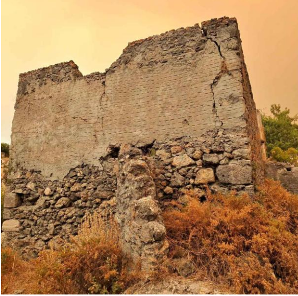
Görsel 4. Kayaköy’de gözlemlenebilir malzeme bozulmaları: taş ve harç kaybı, yüzey aşınması, çatlak ve fiziksel süreksizlik örnekleri. Kaynak: Yazar arşivi, 2026.
