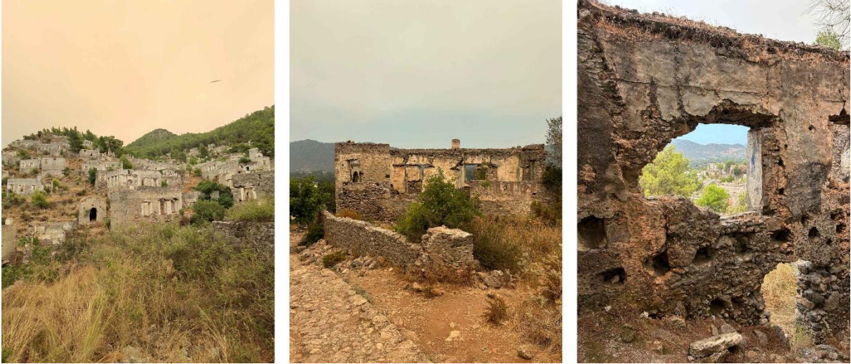
Görsel 2. Fotoğraf temelli saha belgemesinde kullanılan gözlem ölçekleri: yerleşim ölçeği (sol), yapı ölçeği (orta) ve malzeme/yüzey ayrıntısı (sağ). Kaynak: Yazar arşivi, 2026.
