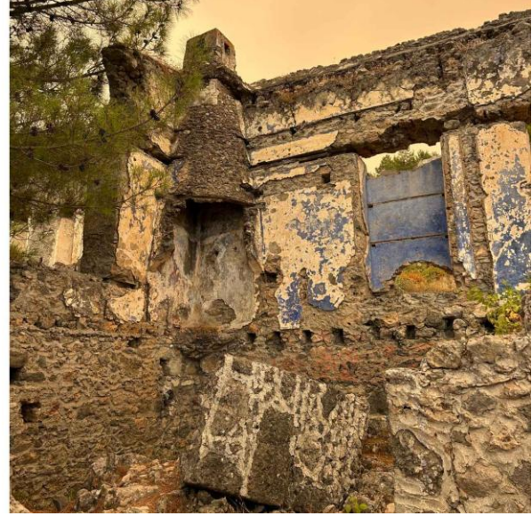
Görsel 4. Kayaköy’de gözlemlenebilir malzeme bozulmaları: taş ve harç kaybı, yüzey aşınması, çatlak ve fiziksel süreksizlik örnekleri. Kaynak: Yazar arşivi, 2026.
